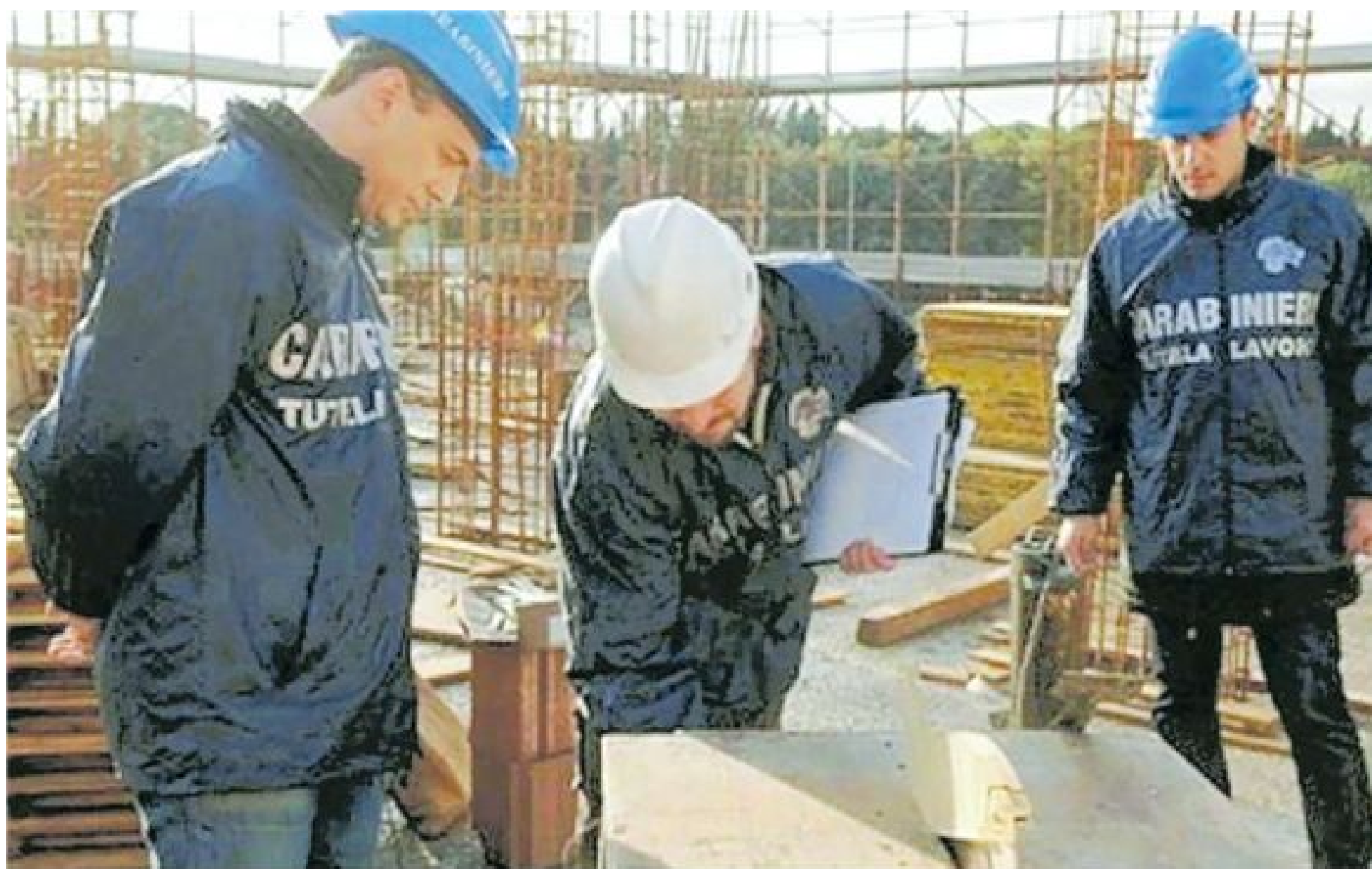
Gli ispettori del lavoro in un cantiere edile
